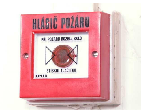
Obrázek č. 15: Vnitřní tlačítkový hlásič požáru MHA 101 [archiv autora]
