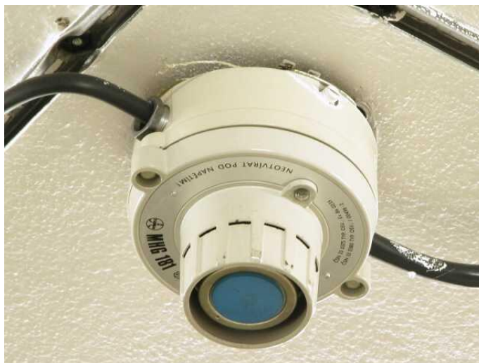
Obrázek č. 13: Ionizační hlásič požáru M 181 [archiv autora]
