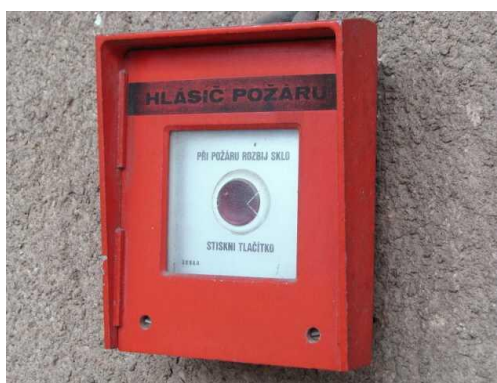
Obrázek č. 16: Venkovní tlačítkový hlásič požáru MHA 102 [archiv autora]
