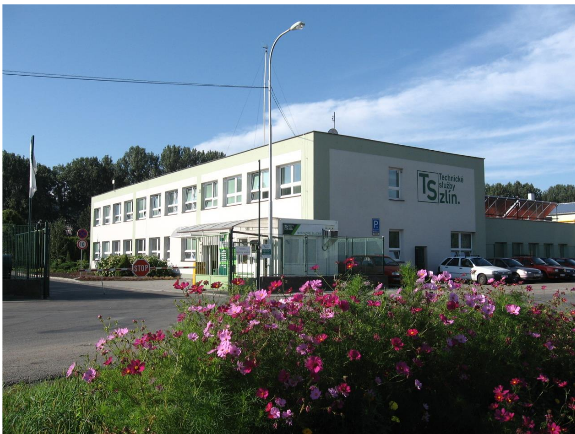
Obrázek 5: Budova vedení společnosti TS Zlín, s.r.o. po rekonstrukci
