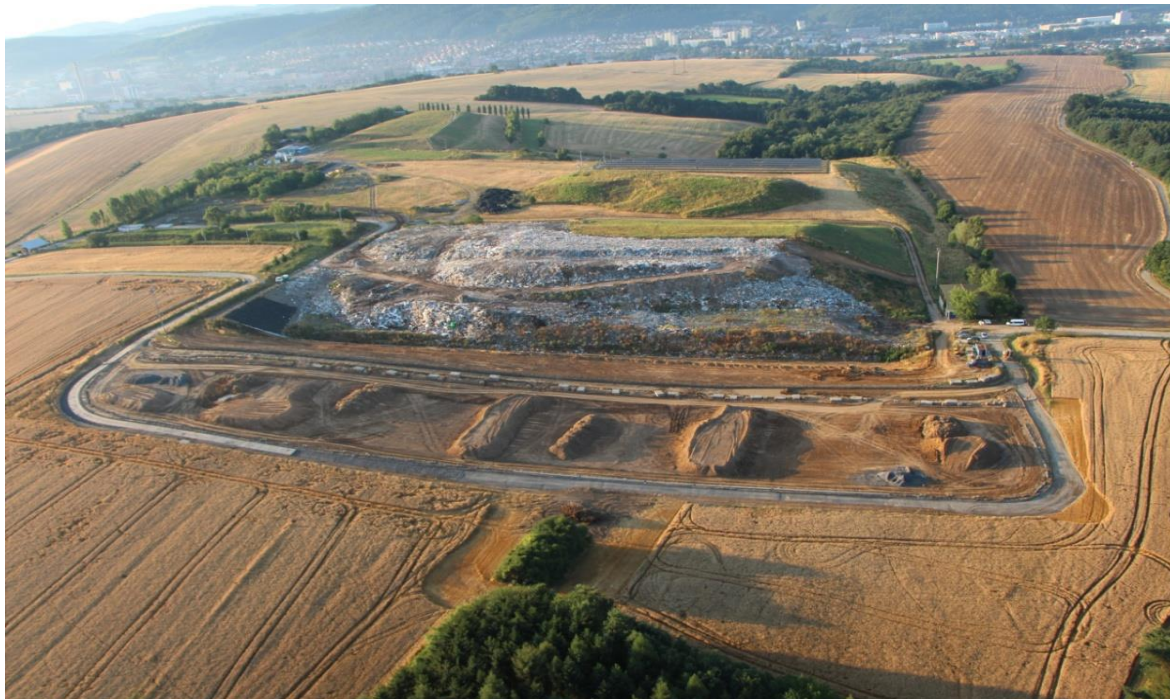
Obrázek 6: Areál skládky Suchý důl směrem od jihovýchodu
