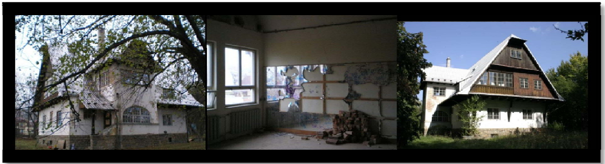
Obr. 6 SVČ Včelín před rekonstrukcí [17]
