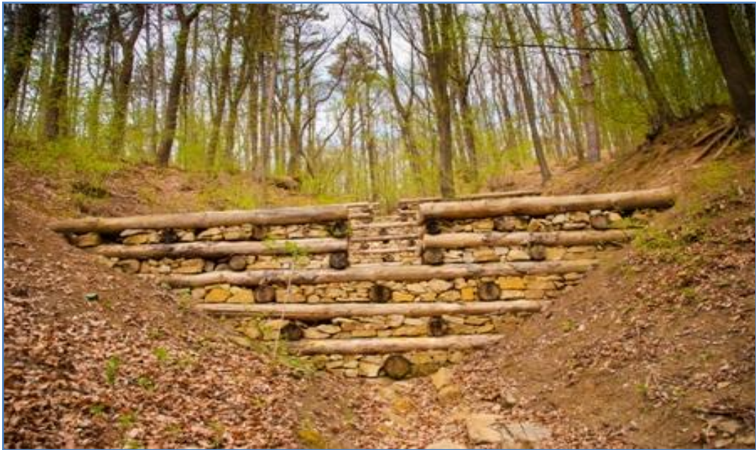
Obrázek 11 Terasovité hráze s přepadem [zdroj: vlastní]
