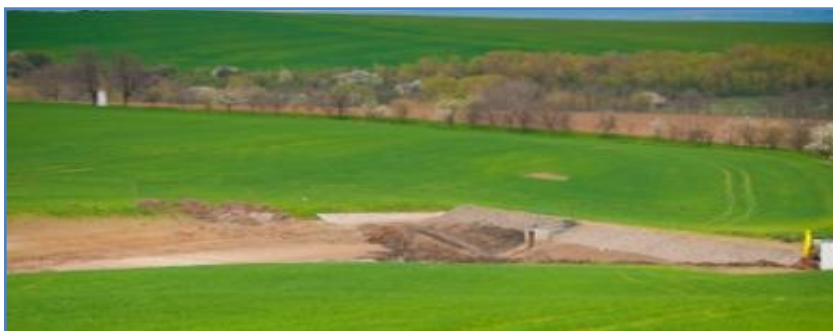
Obrázek 53 Víceúčelová nádrž Veselské Padělký [zdroj: vlastní]
