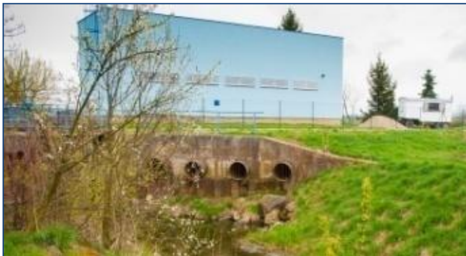
Obrázek 66 Přečerpávací stanice Uherský Ostroh [zdroj: vlastní]
