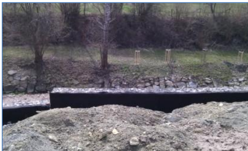
Obrázek 24 Zpevnění svahu [zdroj: vlastní]
