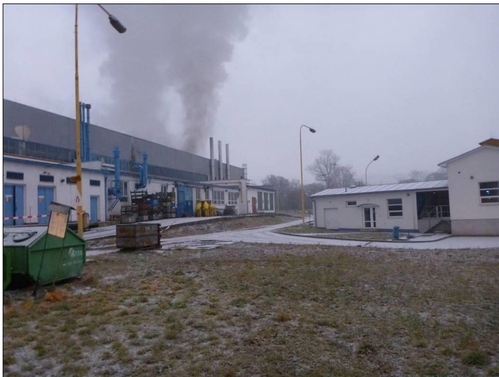
Vstup do objektu [27]
