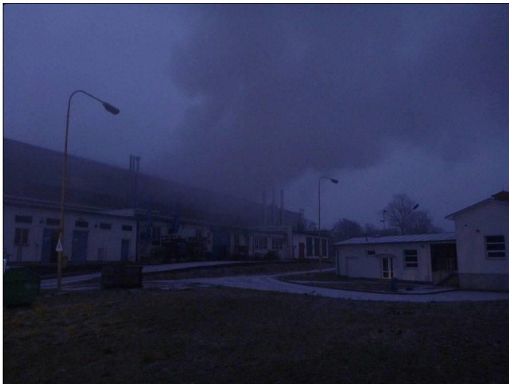
Pohled na halu galvanovny [27]
