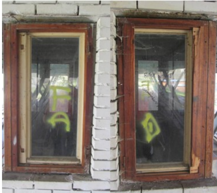
Obrázek 9: Vytrhané okenice [ zdroj: vlastní ]
