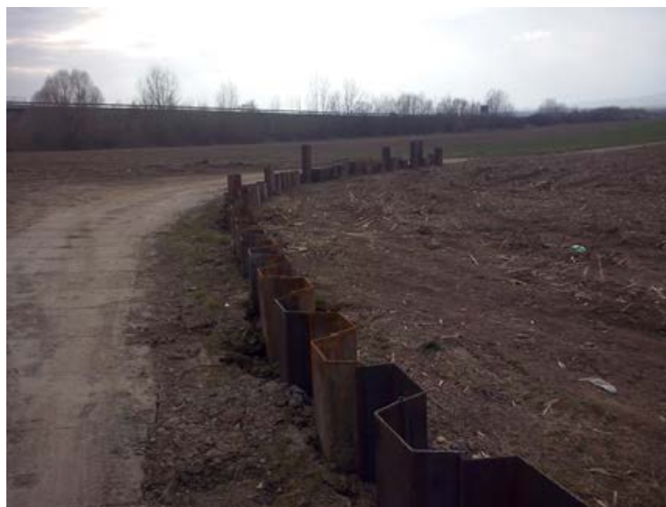
Obrázek 2 – Podpěrná svahová stěna [Zdroj vlastní]
