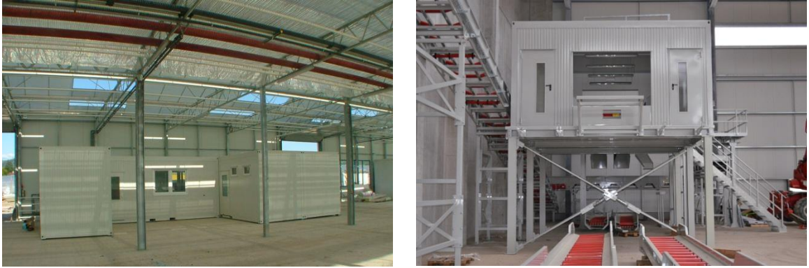
Obr. č. 22: Ukázka z dokončovacích prací
