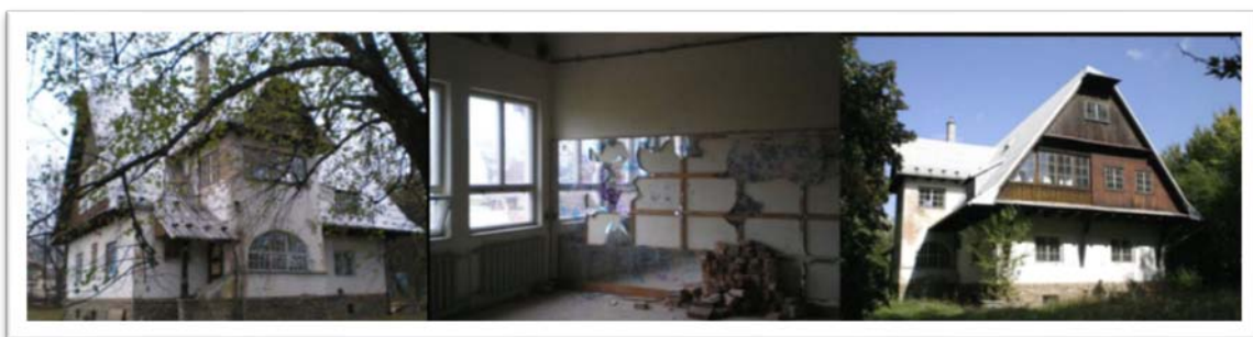
Obr. 8 SVČ Včelín před rekonstrukcí [17]
