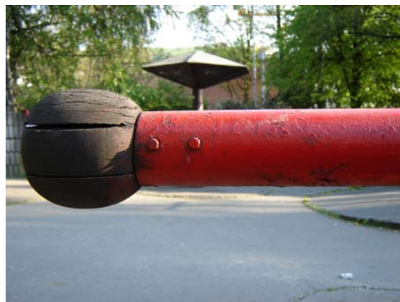
Obr. 32. Detail popraskaného dřeva
