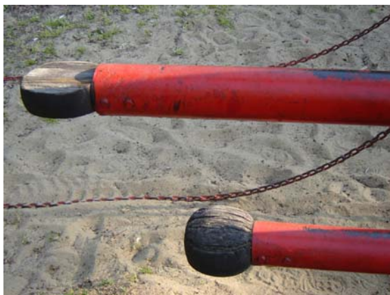
Obr. 31. Detail odlupujících se nátěrů
