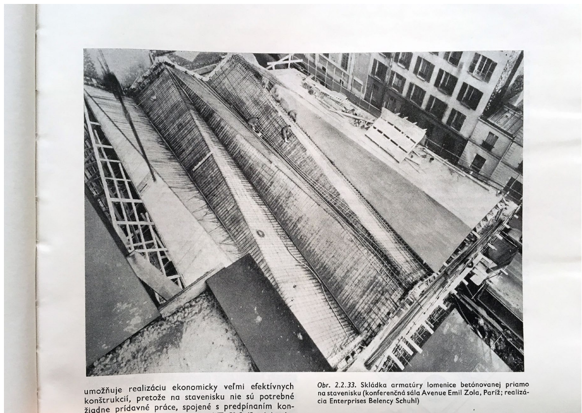
Obr. 10. Skládka armatury betónovej lomenice
