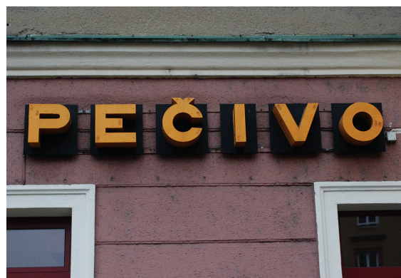
Obr. 17: Detail nápisu – Pečivo (po rekonstrukci)
