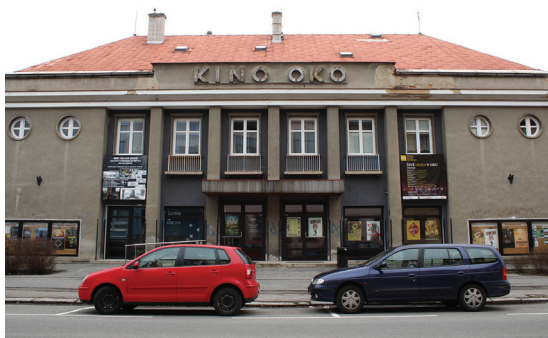
Obr. 34: Kino Oko, Šumperk (stav k r. 2016)
