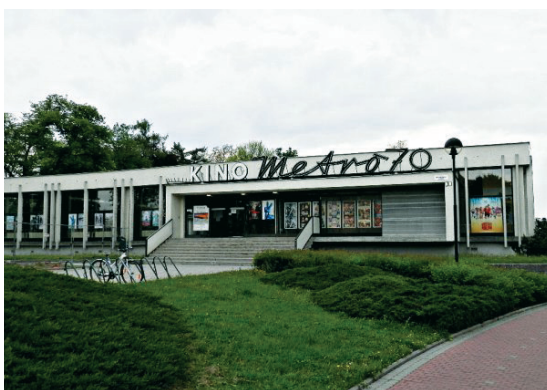
Obr. 44: Kino Metro 70, Prostějov (stav k r. 2016)
