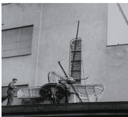
Obr. 24: Montáž Edisonovy transformační stanice
