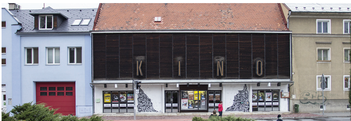
Obr. 39: Naše kino, Šternberk (stav k r. 2015)
