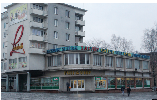
Obr. 18: Budova Labužník , Havířov (stav k r. 2016)
