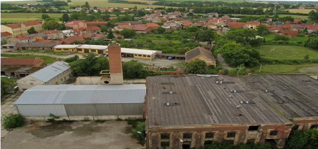
Obrázek č.13 Areál bývalého cukrovaru v Čelechovicích na Hané
