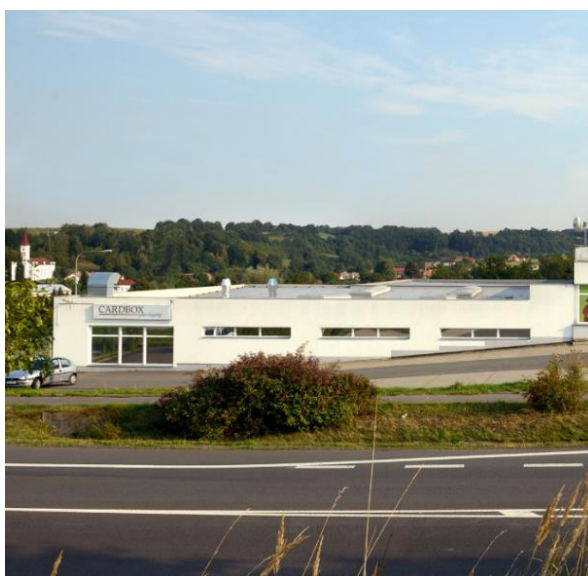
Obrázek 2 Provozovna v Zádveřicích u Zlína
