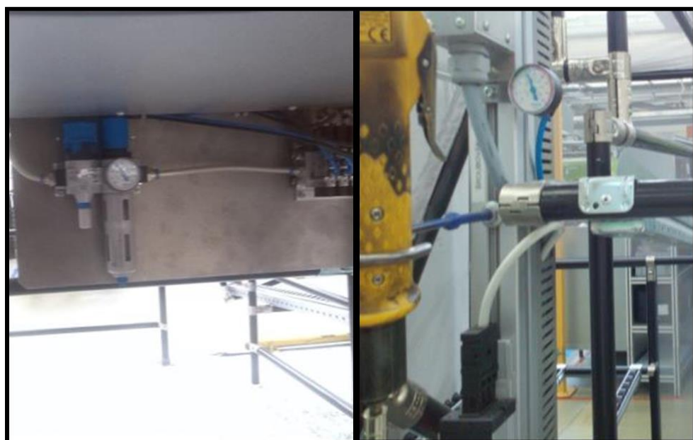
Obrázok 60: Premiestnenie kontrolky merača vzduchu (Vlasté spracovanie)
