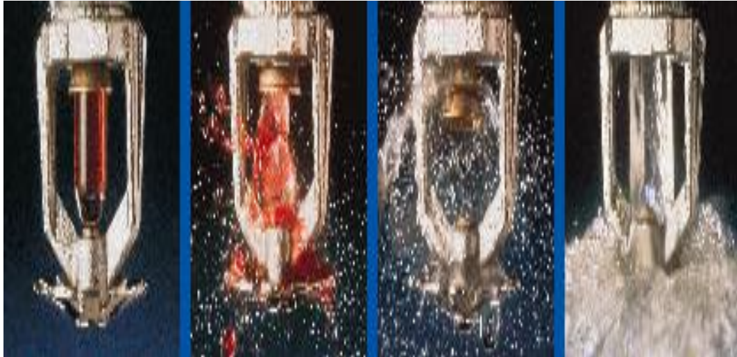
Obr. 31 Aktivace sprinklerovy hlavice
