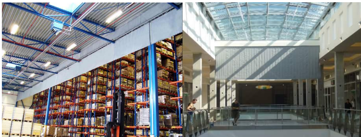
Obr. 69 Kouřové zábrany
