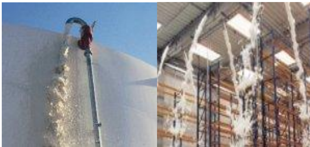
Obr. 35 Pěnová hasicí zařízení
