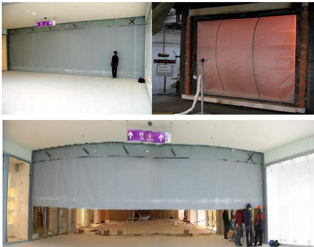
Obr. 68 Roletové požární uzávěry
