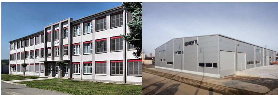
Obr. 5 Sídlo společnosti a výrobní hala organizace A
