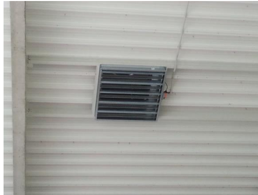
Obr. 27. Ventilátor ve střeše [vlastní zpracování]
