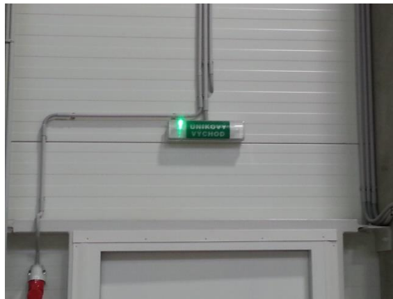
Obr. 12. Nouzové osvětlení únikových míst [vlastní zpracování]
