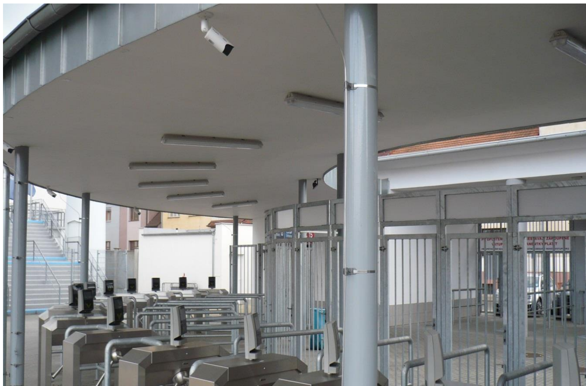
Obr. č. 7. Vstupní prostor na stadion
