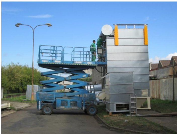
Obr. 9. Práce pracovníků montáže s plošinou (vlastní)
