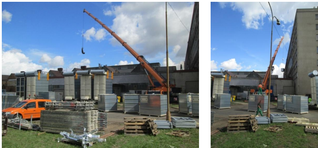
Obr. 5., Obr. 6. Práce s jeřábem při montáži filtrů v daném provozu (vlastní)
