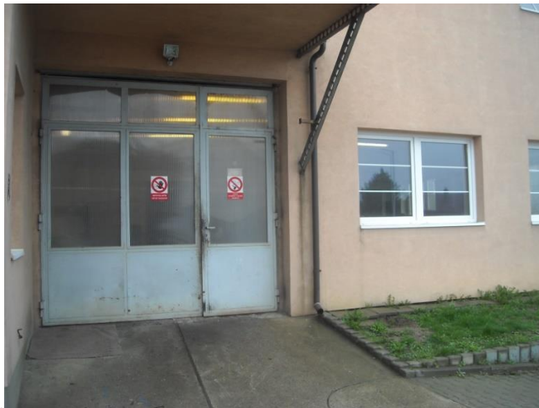
Obrázek 20 Pohled na vrata hlavní budovy
