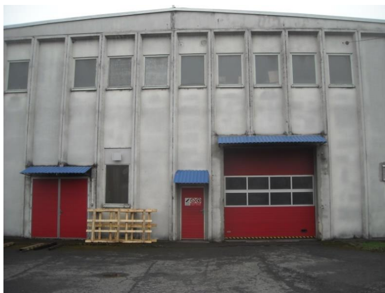
Obrázek 19 Pohled na budovu výrobní haly
