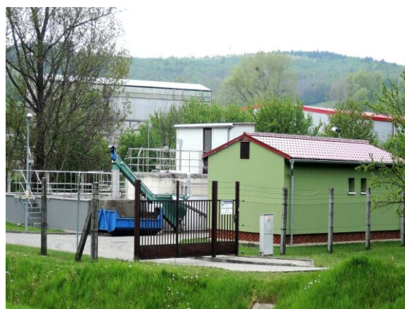
obr. 16 Čistička odpadních vod Uhřice
