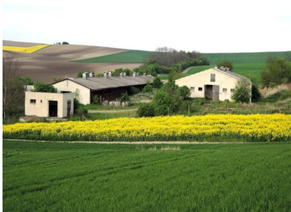
obr. 19 Bývalý objekt JZD (u Žarošic)
