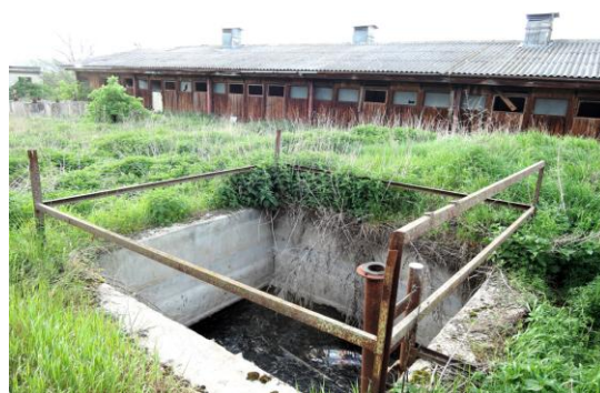
obr. 20 Bývalý objekt JZD (u Žarošic)
