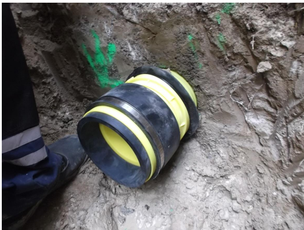
Obr. 14: Navrtávka stoky osazena sedlovou odbočkou (zdroj: vlastní)
