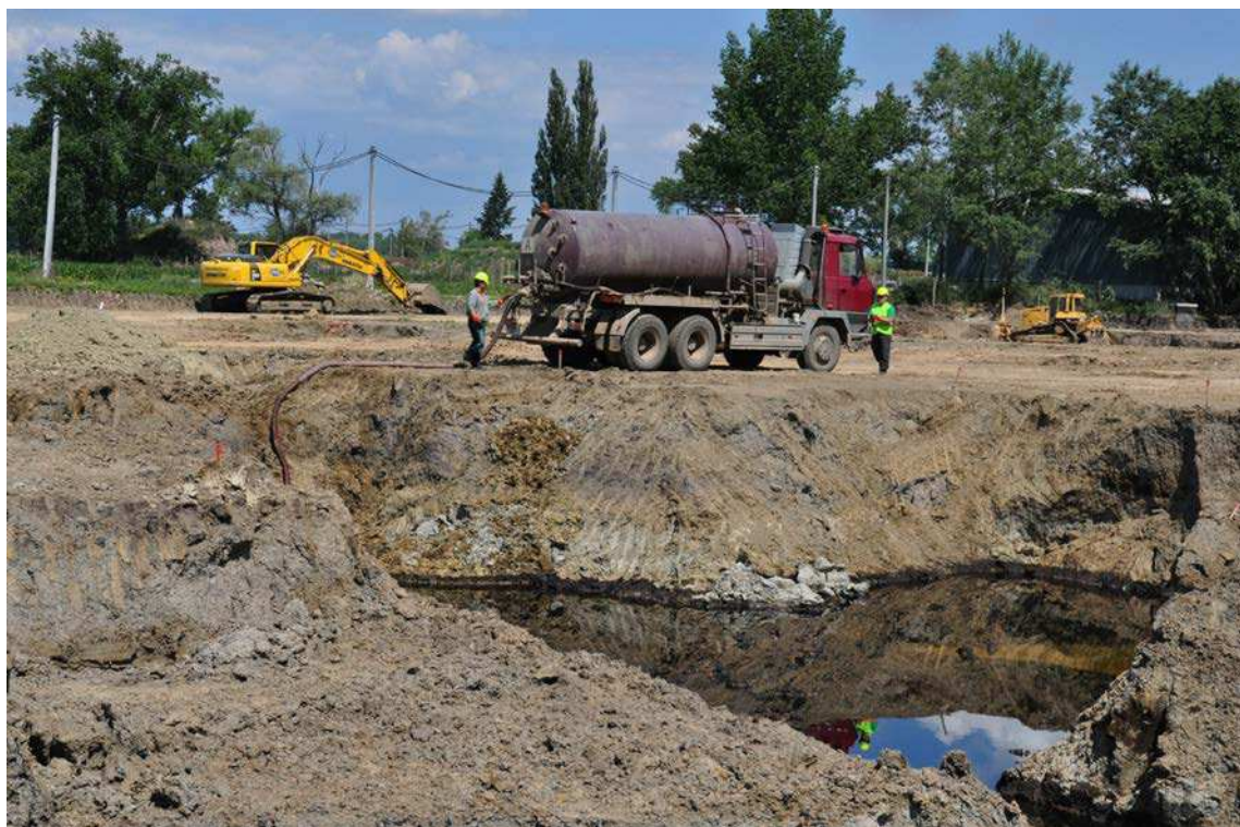
Obrázek 28: Sanační práce – čerpání kontaminované vody ropnou fází z výkopu [zdroj PKÚ, a. s.]
