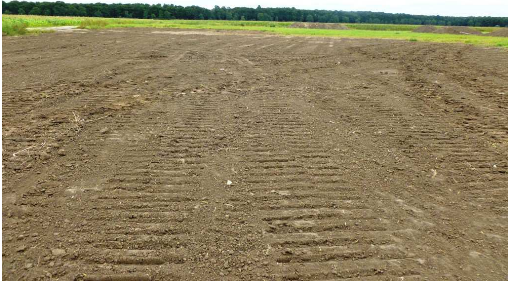
Obrázek 34: Stav po zpětném zásypu, Hodonín [zdroj PKÚ, a. s.]
