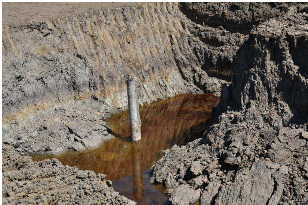
Obrázek 27: Sanační práce nastupující hladina podzemní vody a ropné fáze na hladině, Hodonín [zdroj PKÚ, a. s.]
