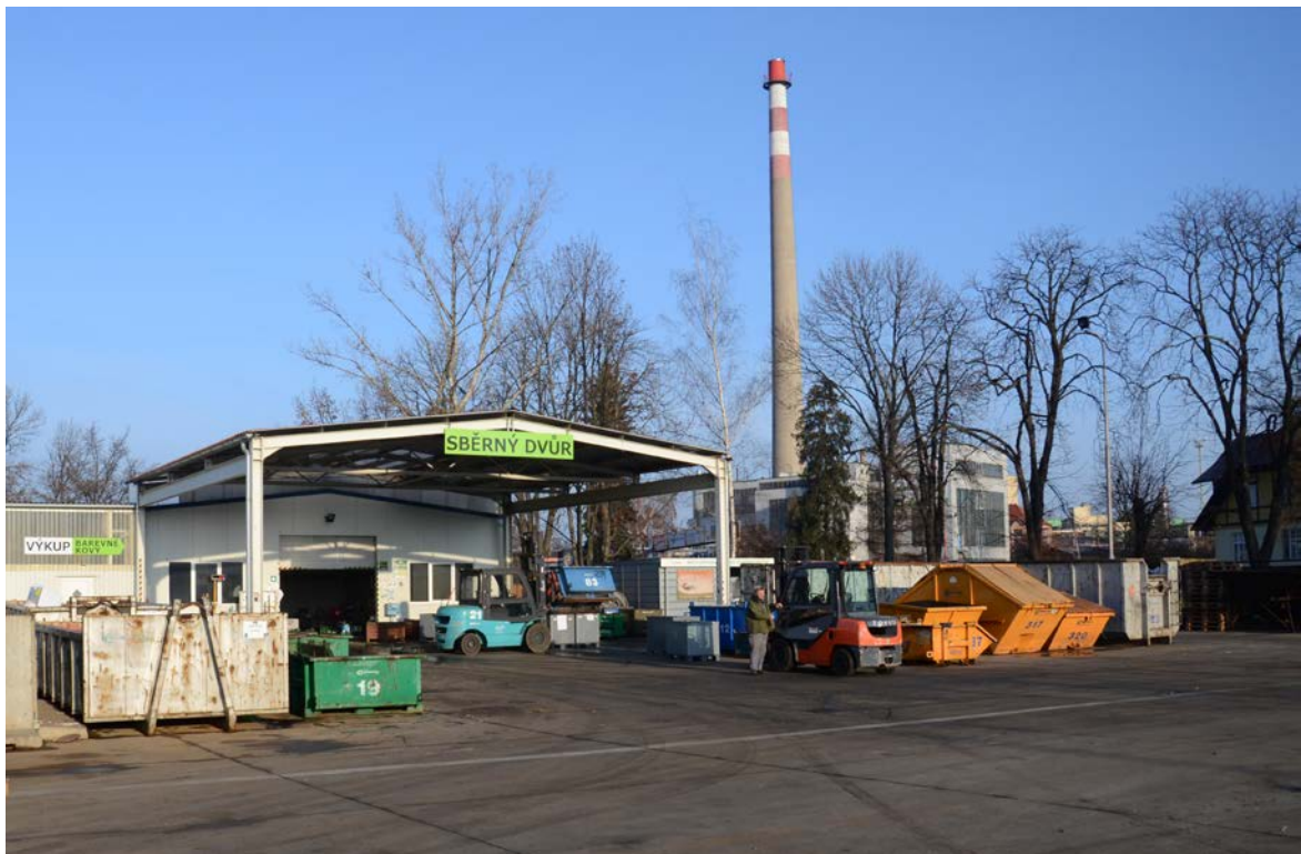
Obrázek 1 – Pohled na sběrný dvůr u vjezdu do parku [Kovosteel Recycling]
