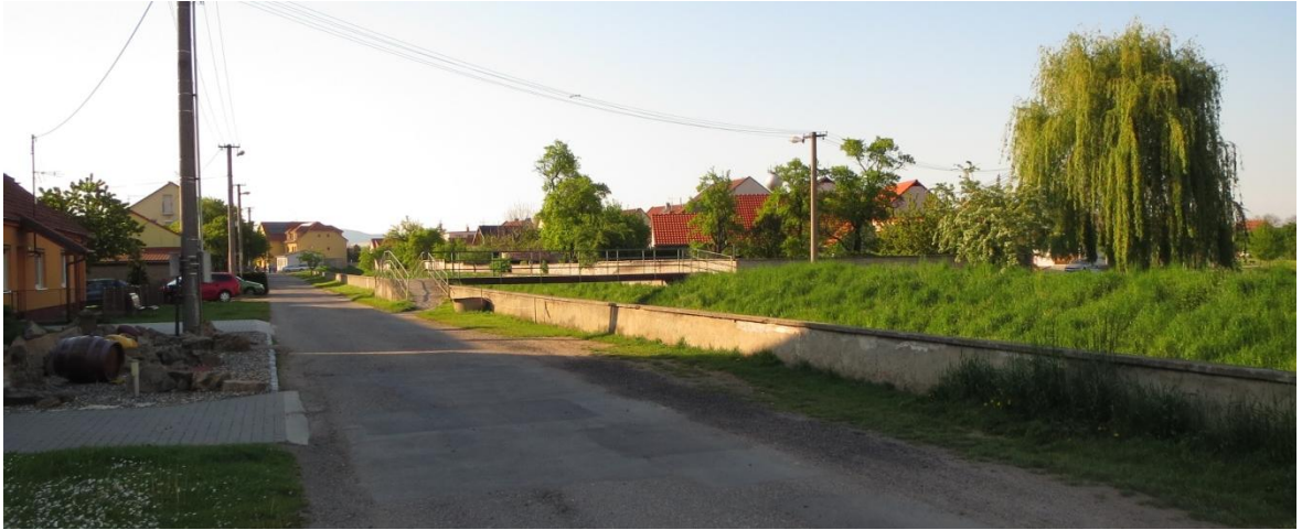
Obr. 16 Zvýšená betonová hráz potoka
