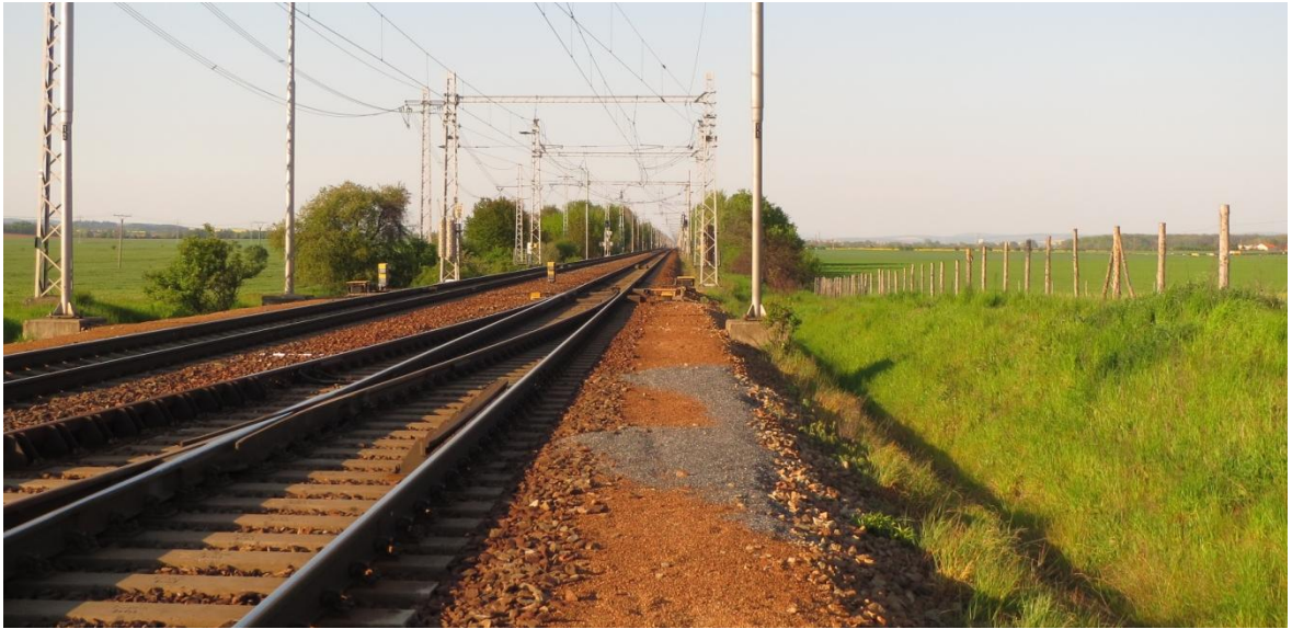
Obr. 24 Železniční trať ve směru Přerov
