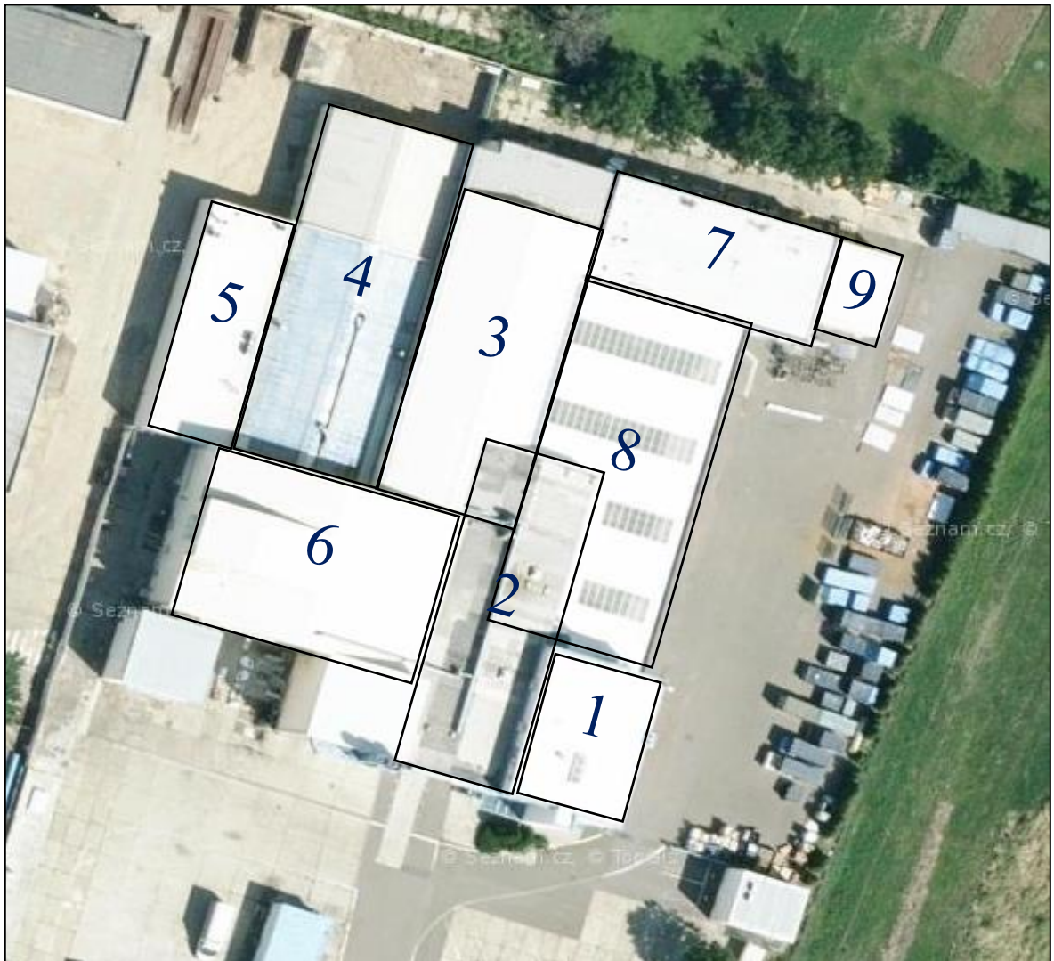
Obrázek 2: Letecký pohled na areál společnosti DFK Cab, s.r.o. se zakreslením jednotlivých objektů [17]
