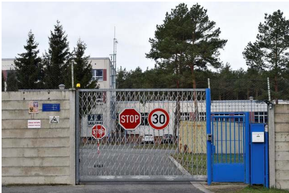
Obr. č. 4 – Věznice Břeclav – objekt Poštorná [45]
