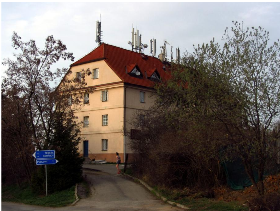
Obr. 12. Budova s nezabezpečeným vysílačem BSS. [ zdroj vlastní]
