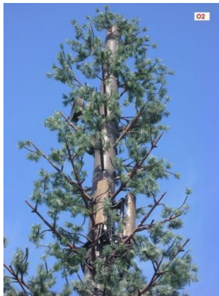
Obr. 3. BTS maskovaná v lesním porostu. [10]
