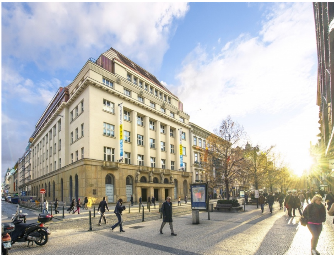
Obr. 13 Nově vznikající obchodní centrum Na Příkopě 14 [18]
