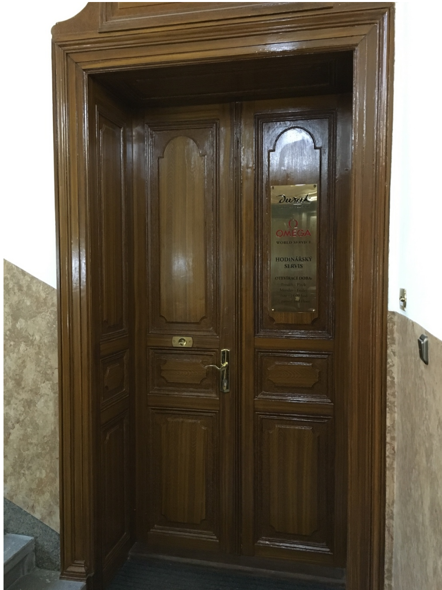
Obr. 19 Vstup do servisní části objektu
