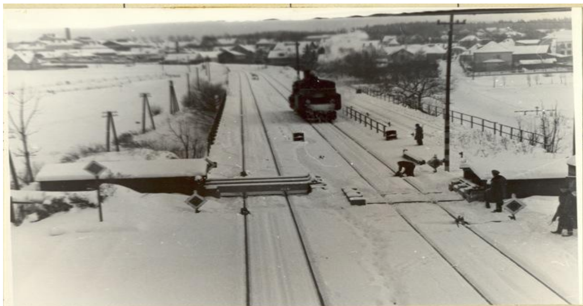
Obrázek 4 – železniční přechod s posuvným zátarasem [5]
