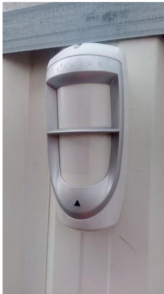
Obr. 1 - Venkovní PIR detektor DG85 Standard
