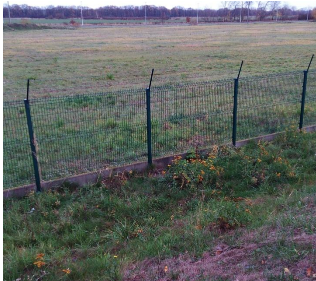
Obr. 21 - Obvodová ochrana - oplocení s ostnatými dráty
