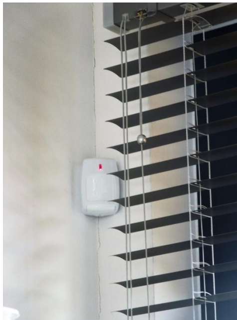
Obr. 11 Aktuální umístění PIR detektoru ve školce. [Foto autor]
