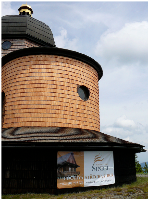
Obr. č. 4 Banner k dočasnému označení stavby
