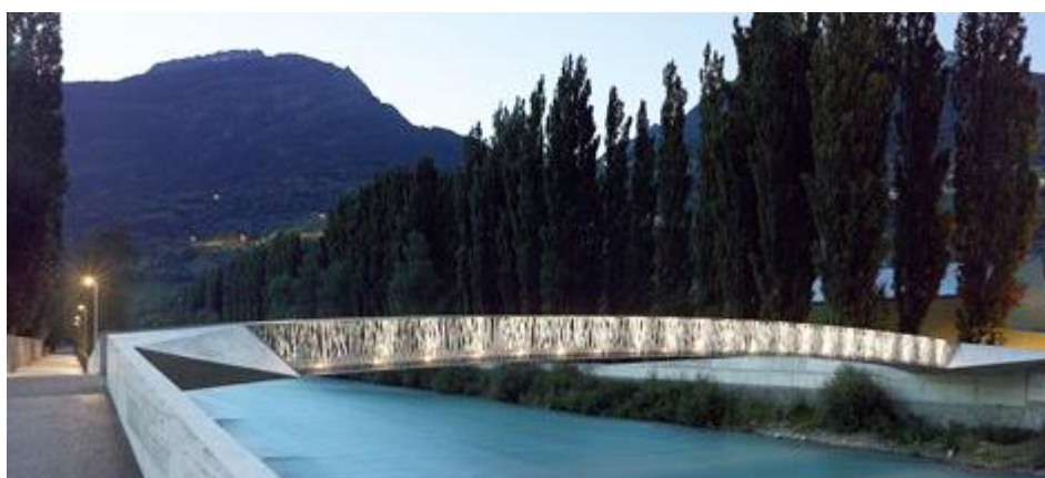
Obr. 68 The Footbridge Over The Vispa – nasvícení lávky
