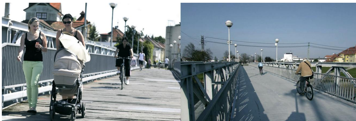
Obr. 53 Lávka mezi UH a SM – vlevo před rekonstrukcí a vpravo po opravě
