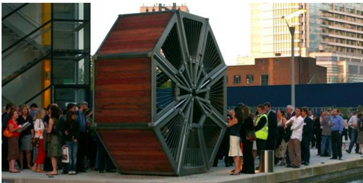
Obr. 70 The Rolling Bridge – uzavřená lávka
