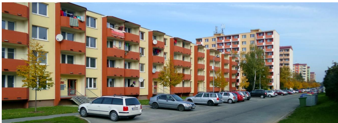
Obr. 7 Panelové domy na sídlišti Nábřeží
