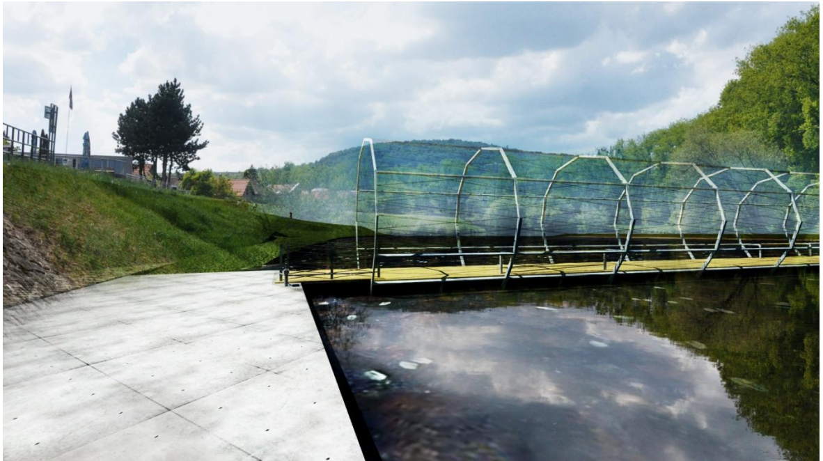
Obr. 106 Ukotvení lávky u mola, průchozí varianta
