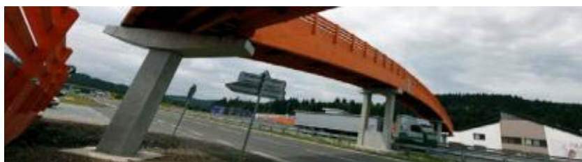
Obr. 49 60 m dlouhá lávka přes rychlostní silnici Vsetín – Bobrky
