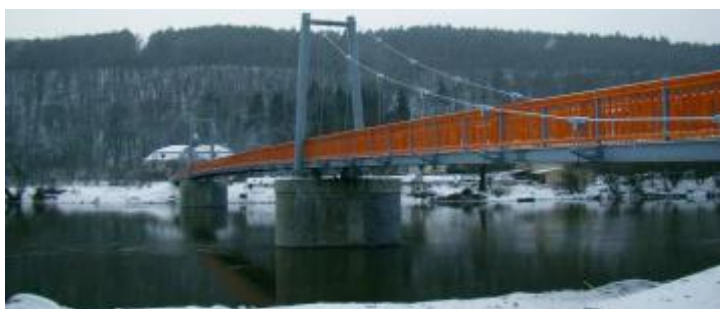
Obr. 45 Lávka přes Berounku na cyklostezce
