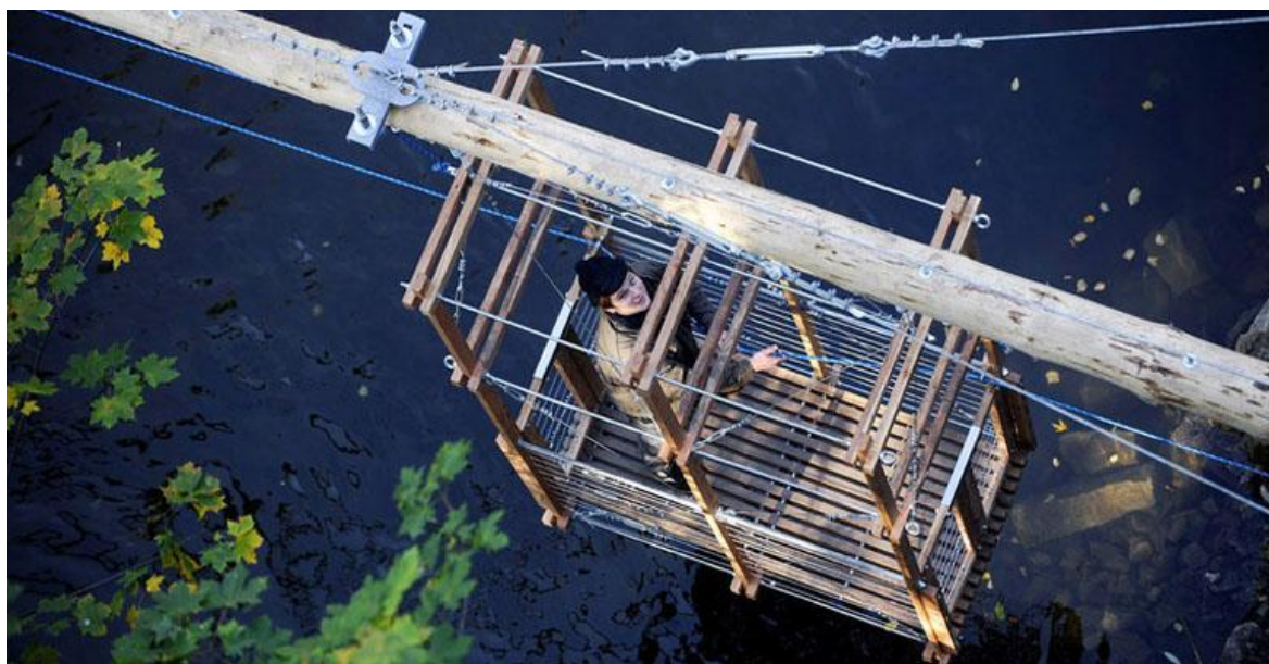
Obr. 79 Transbordér od Martina Rajniše – pohled z ptačí perspektivy – detail kabiny
