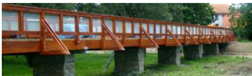
Obr. 51 Lávka v Dačicích
