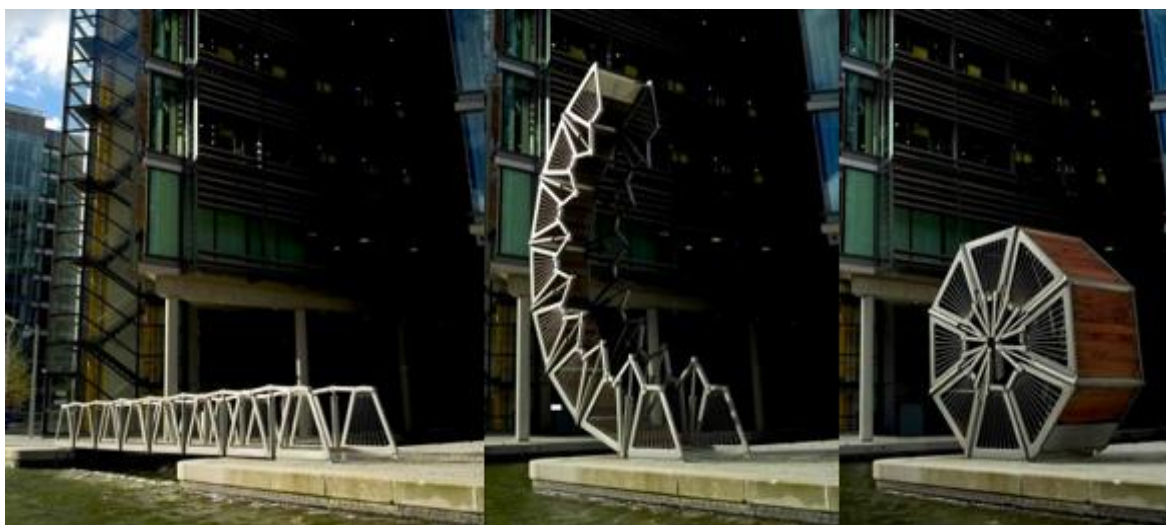
Obr. 69 The Rolling Bridge – fáze pohybu
