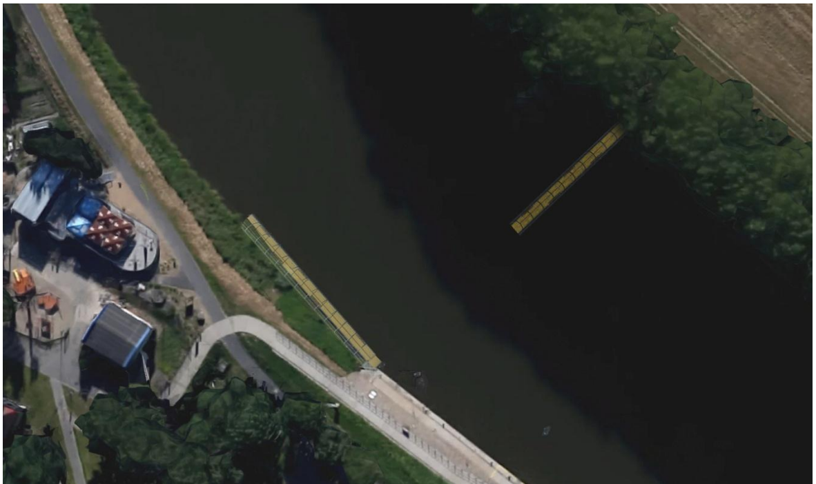
Obr. 111 Otevřená lávka za plného provozu
