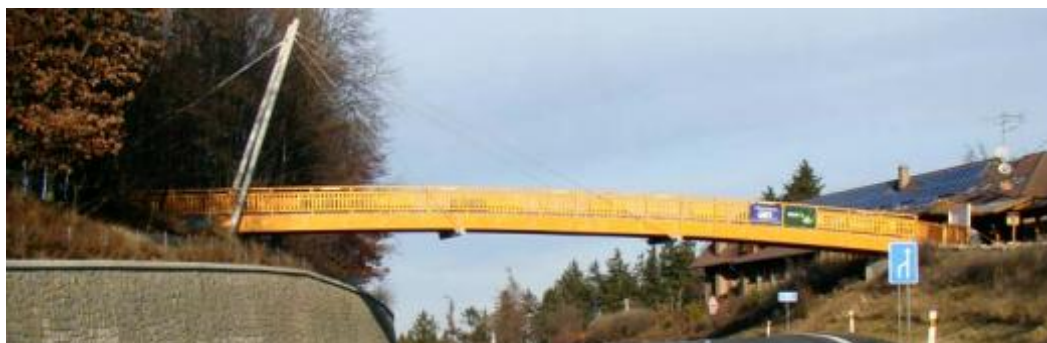
Obr. 47 Lávka Samota přes I/50 nedaleko Zlína
