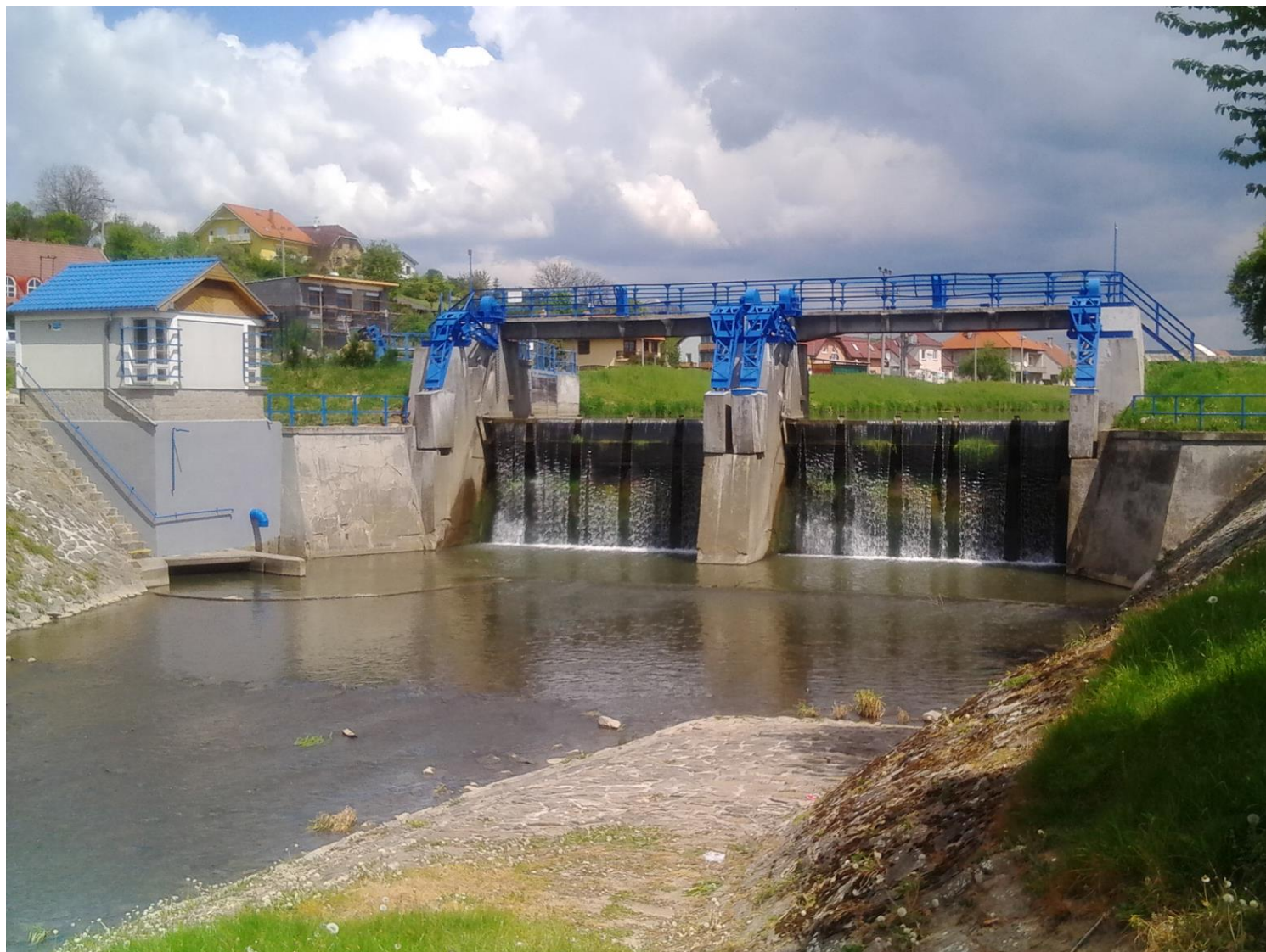
Obr. č. 4 Malá vodní elektrárna na vodním toku Olšava [31]
