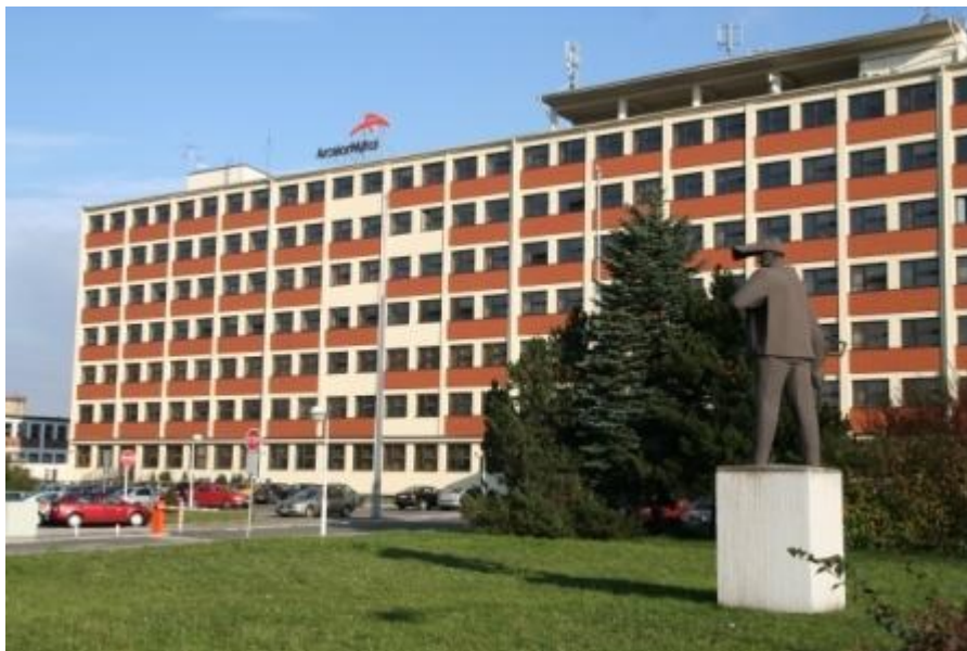
Obrázek 9 Budova ředitelství ArcelorMittal Ostrava a.s.
