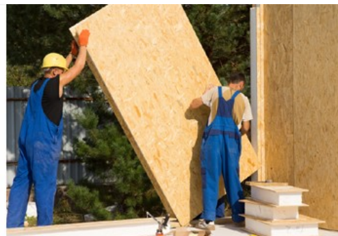
Obrázek 6: Montáž SIP panelů.
