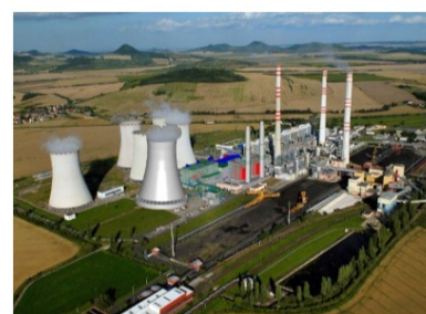
Rekonstrukce kotle Moravských tepláren
