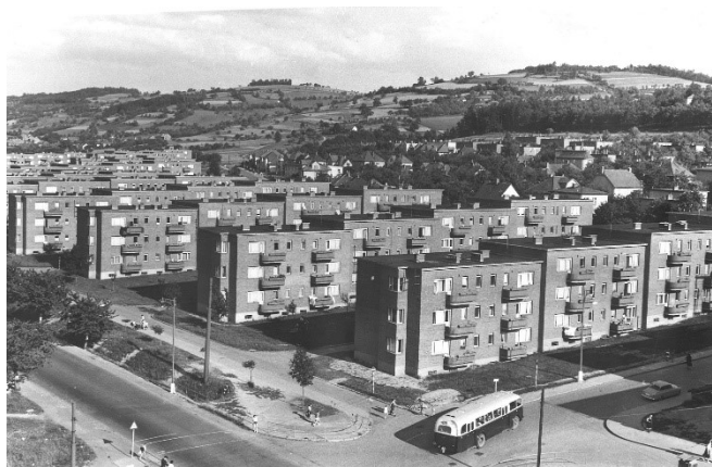
Obrázek 3 Třítážové obytné domy (Centroprojekt, 2017)
