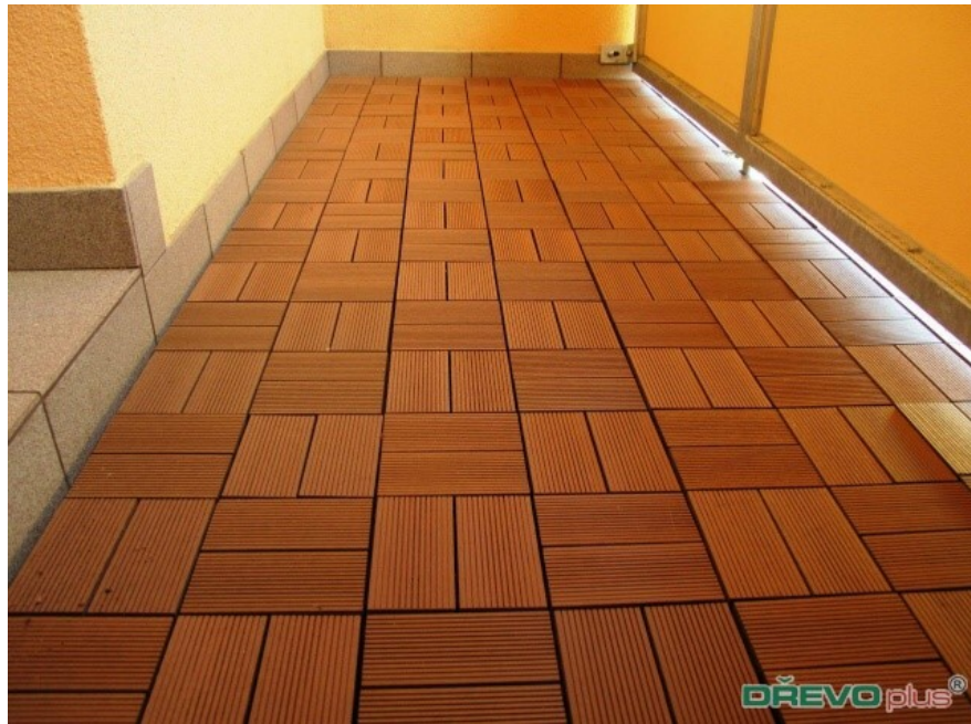
Obrázek 4: Ukázka realizace podlahových kazet
