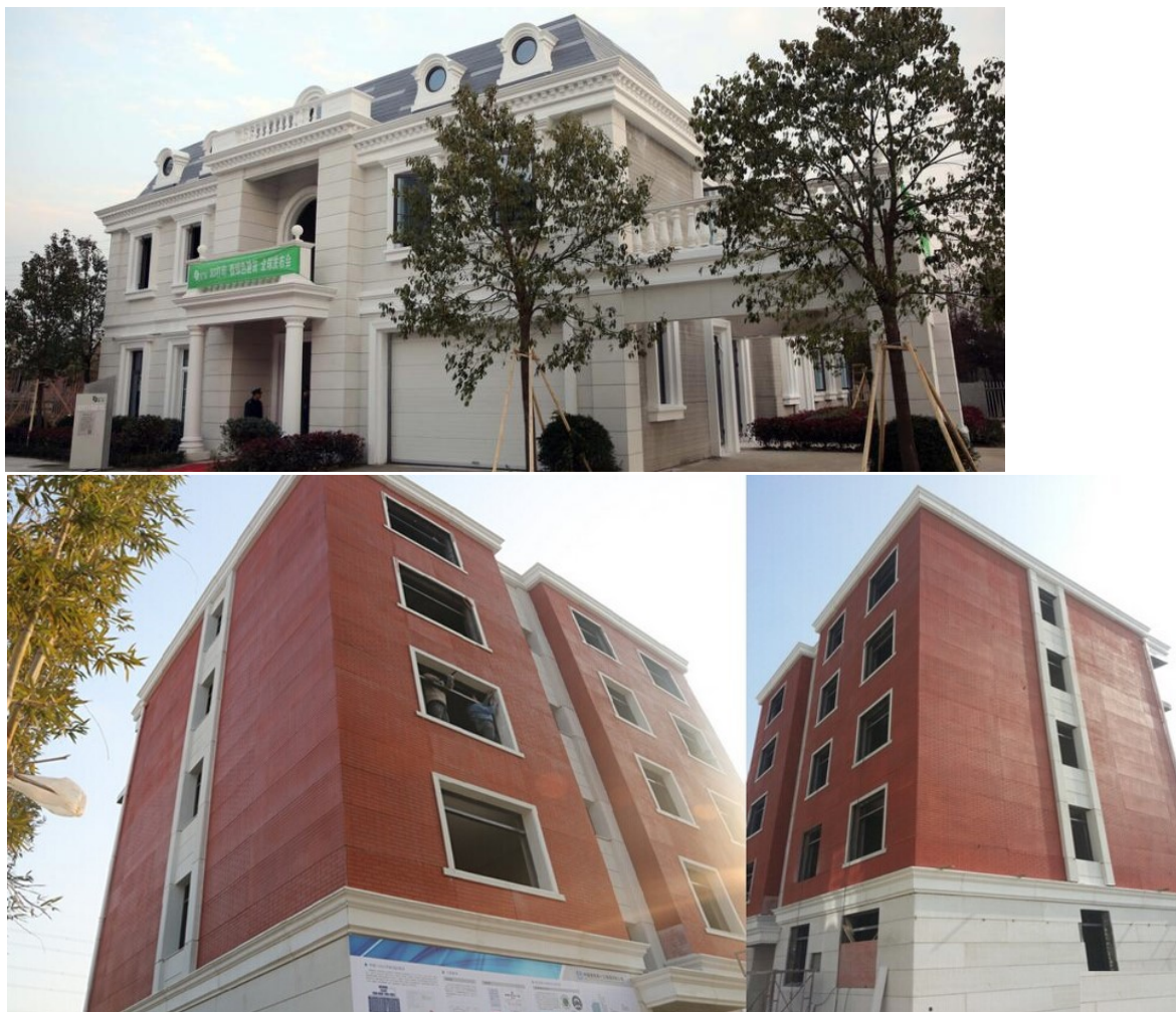
Obr. 14 Vila a pětipatrový dům vytištěný na 3D tiskárně [16]
