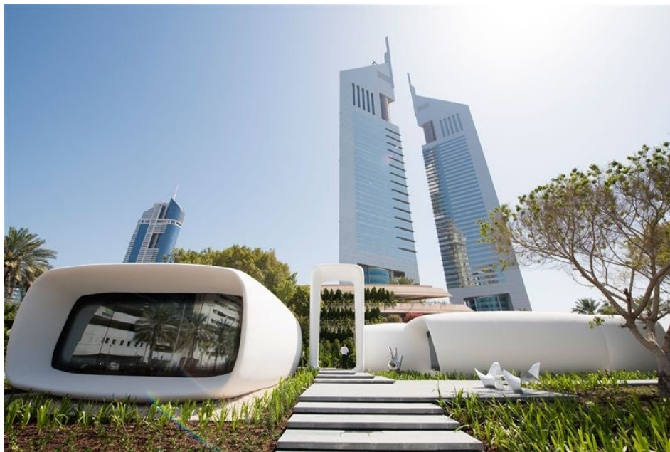
Obr. 15 Kancelářský komplex v Dubaji vytištěný na 3D tiskárně [17]
