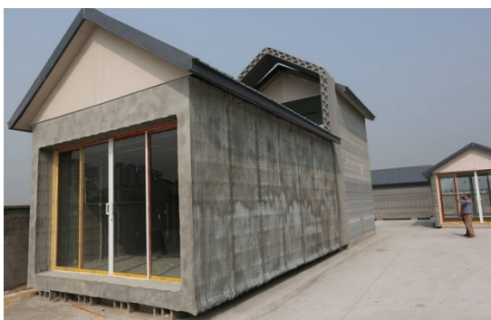
Obr. 13 Vytištěný dům z betonu [15]
