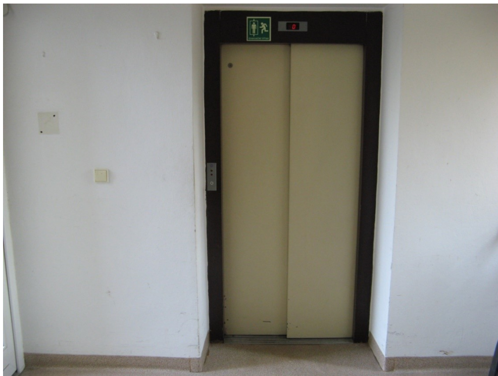
Obr. 10. Evakuační výtah [Zdroj: Vlastní]
