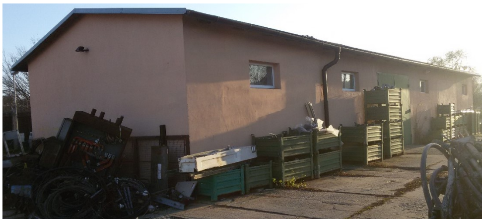
Obr. 12. Venkovní skladování elektroinstalačního materiálu 2
