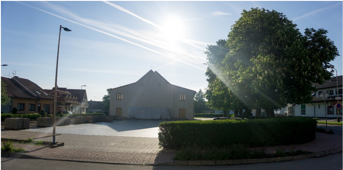
Obr. 8 Venkovní prostory areálu [vlastní]
