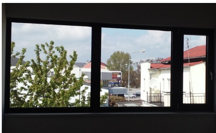
Obrázek 14 – Okna ve 2.NP společnosti Dřevo Trust Olomouc [Zdroj: vlastní]
