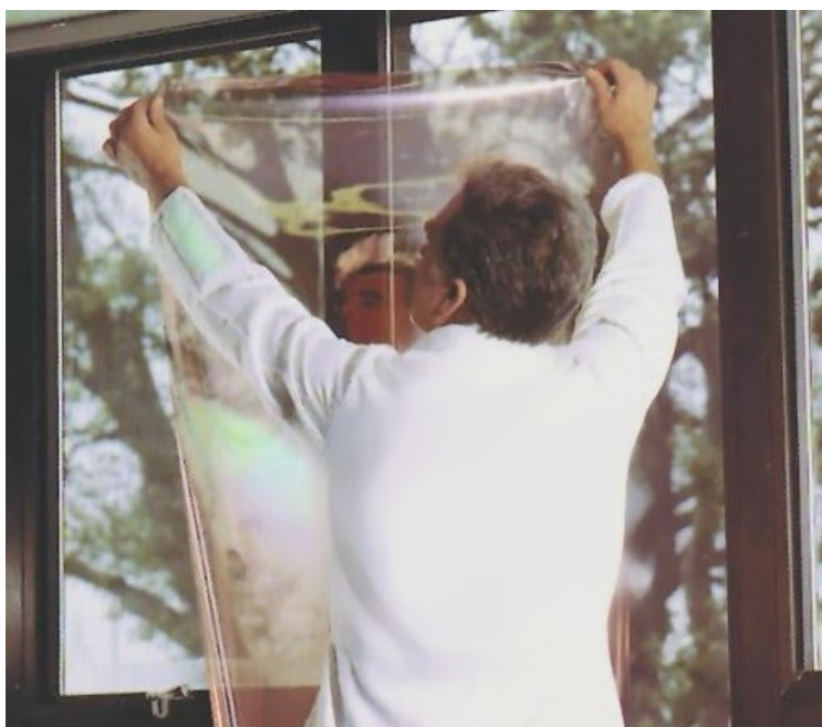
Obrázek 8 – Instalace bezpečnostní fólie [23; upraveno]
