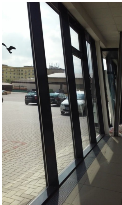
Obrázek 12 – Skleněné stěny v 1.NP společnosti Dřevo Trust Olomouc [Zdroj: vlastní]
