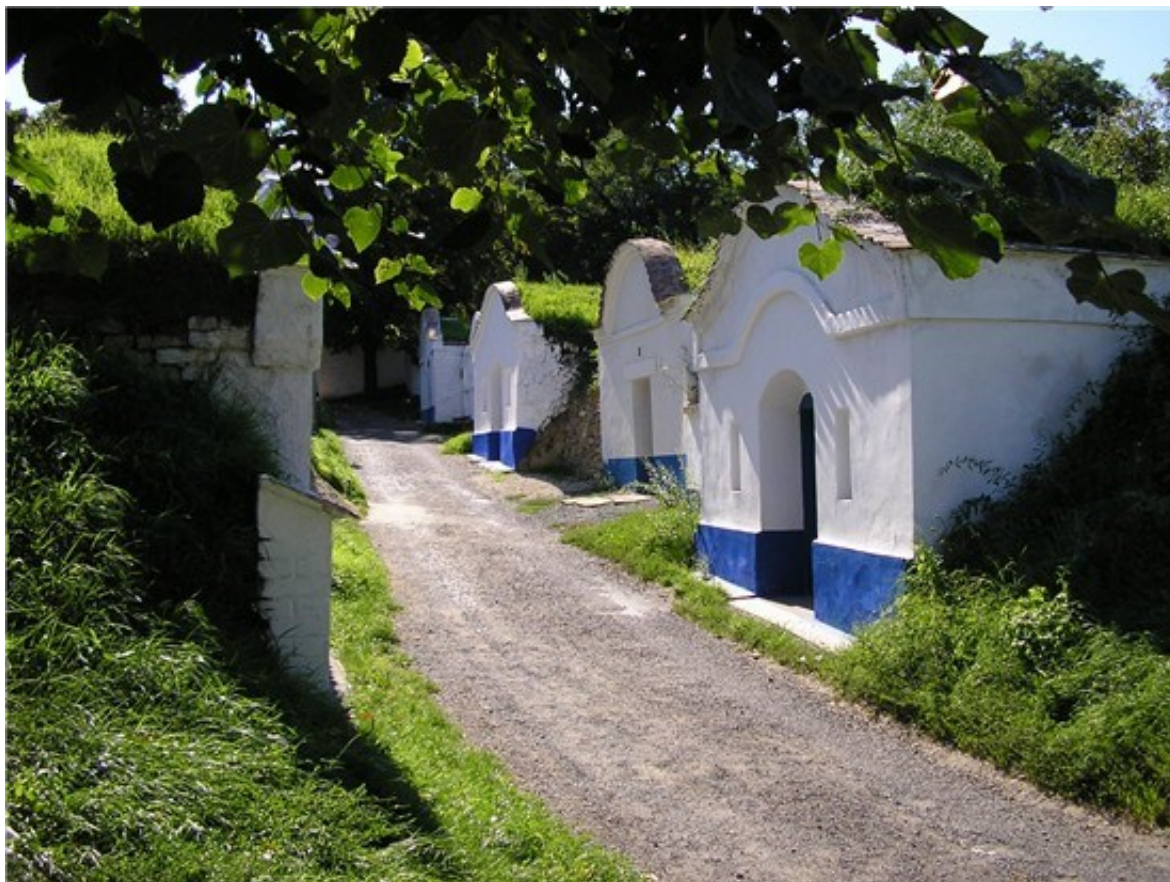
Příloha P 3: Areál vinných sklepů Plže
