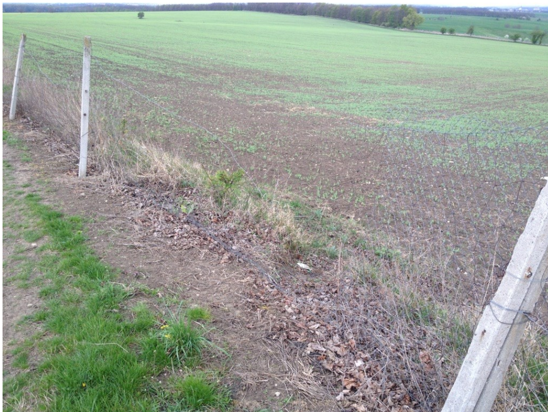
Obr. 24: Poničená část oplocení na severozápadní straně
