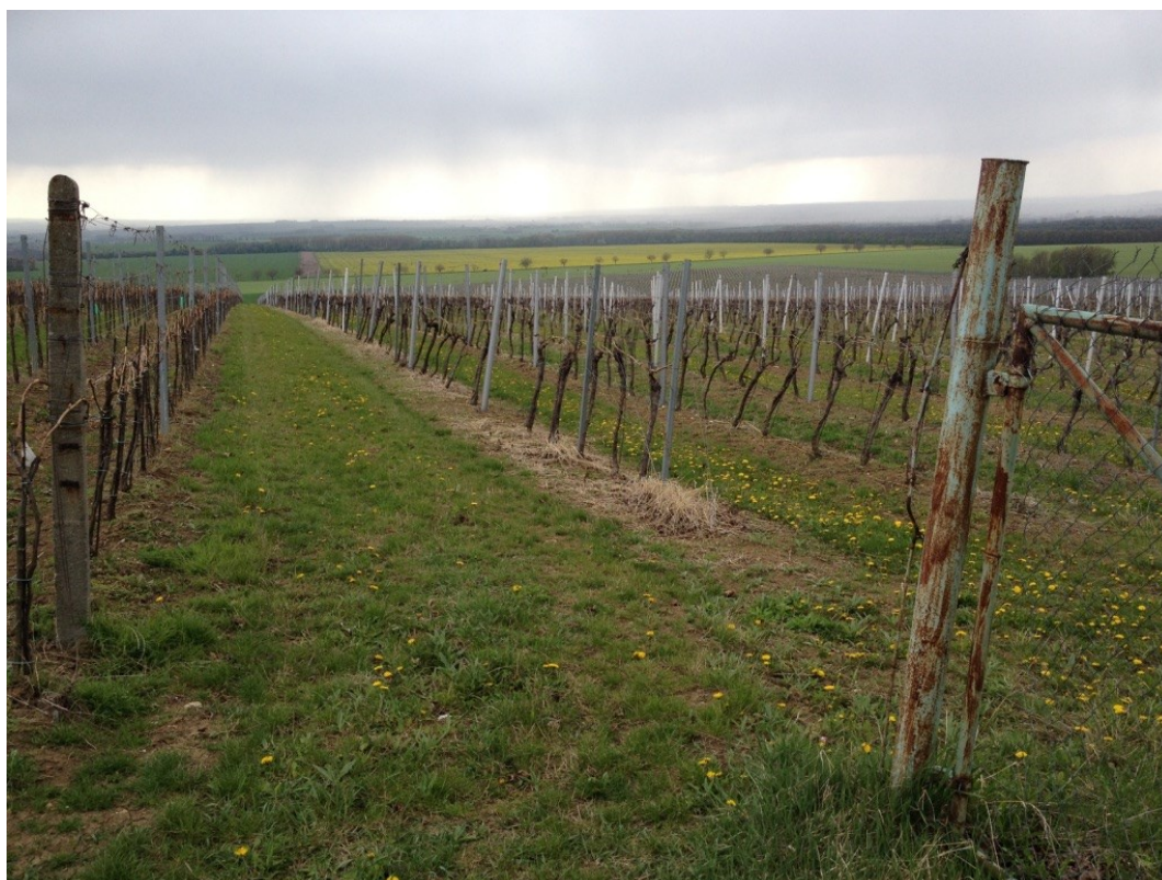
Obr. 17: Nedokončená část oplocení na východní straně
