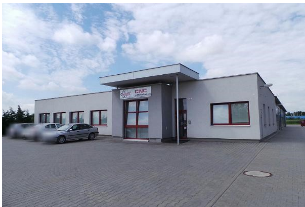
Obr. 2 Sídlo a výrobní hala společnosti SOLID Brno s.r.o. [29]
