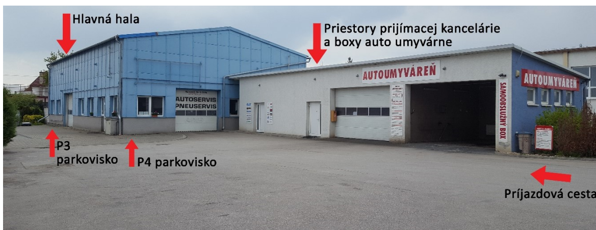
Obr. 17: Pohľad na hlavnú halu a budovu autoumyvárne [zdroj: autor]
