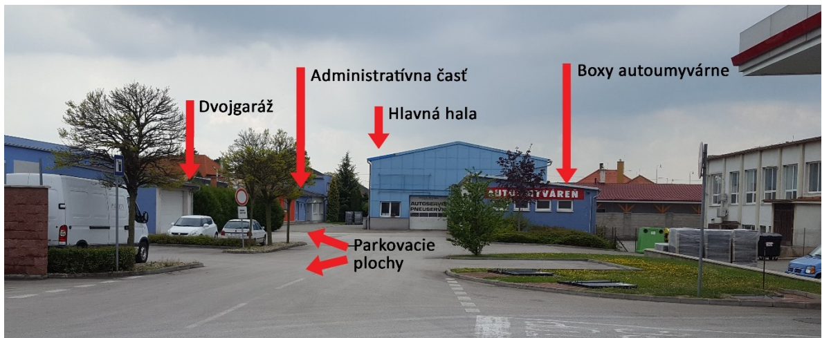
Obr. 13: Priamy pohľad z príjazdovej cesty do objektu firmy [zdroj: autor]
