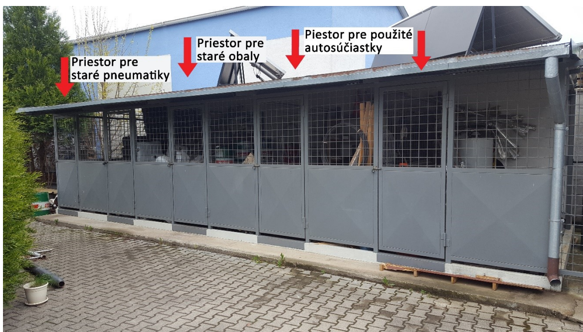
Obr. 16: Pohľad na priestory uchovania použitých komponentov [zdroj: autor]
