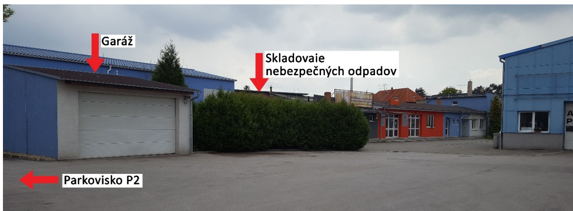
Obr. 20: Pohľad na garáž a stromový porast [zdroj: autor]
