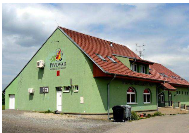
Obr. 12: Budova pivovaru (interní zdroje firmy)
